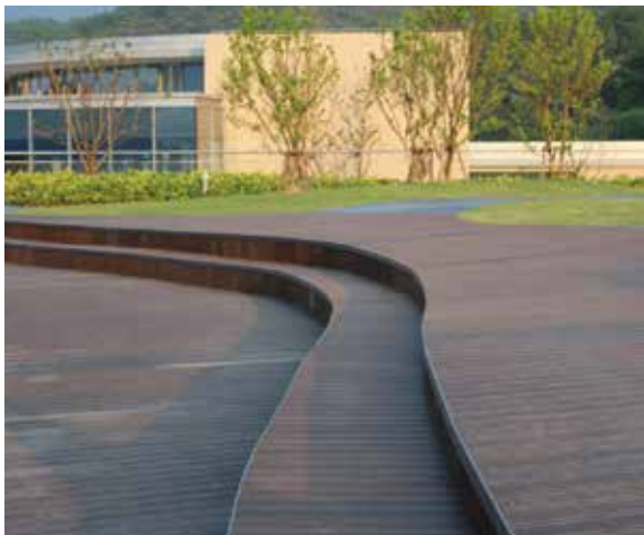
Recién instalado en 2013
